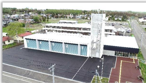
【上士幌消防署 令和3年4月移転新築】
