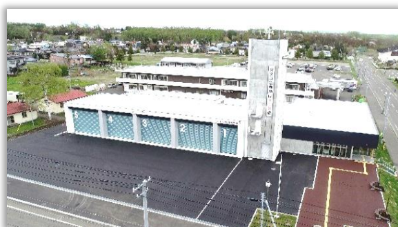
【上士幌消防署 令和3年4月移転新築】
